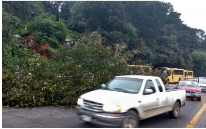
Figura 2.9 Deslizamiento y cierre parcial en la carretera México Toluca por deslave en el kilómetro 22+500 (El Universal, 2017)
