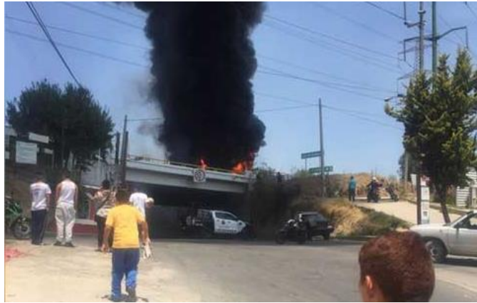
Figura 2.12 Cierre parcial y nula visibilidad por incendio en la carretera Chamapa-Lechería en el kilómetro 5+000, marzo de 2018 (Excelsior, 2018)
