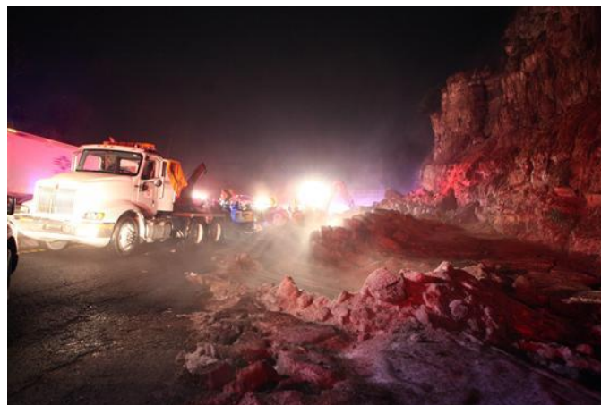
Figura 2.8 Deslave y cierre total de la autopista México-Querétaro en el kilómetro 52+900 (El Universal, 2015)
